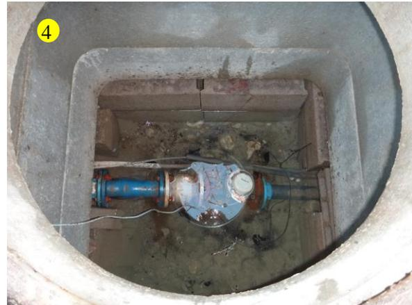
4 - Regard annexe du captage submergé par les eaux bâti en parpaings sans enduit : H = 0.30 m le 14.04.2015
